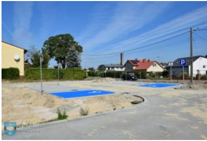
Zakończono I etap budowy placu targowego
