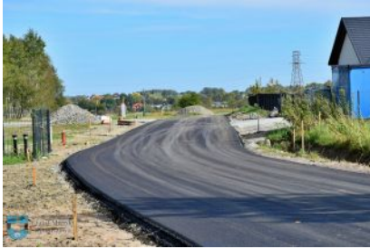
Budowa ul. Sosnowej w Kolbuszowej
