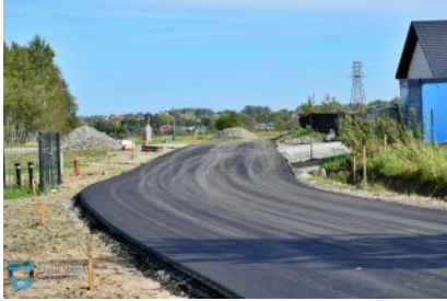
Budowa ul. Sosnowej w Kolbuszowej
