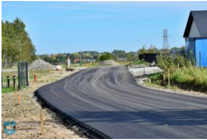
Budowa ul. Sosnowej w Kolbuszowej
