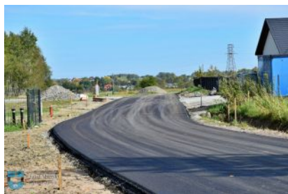
Budowa ul. Sosnowej w Kolbuszowej
