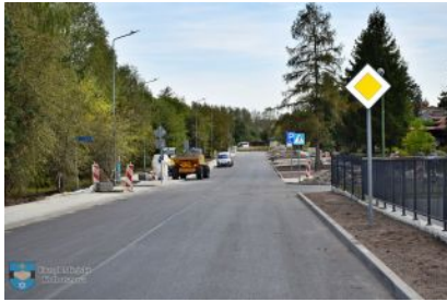
Przebudowa ul. 3 Maja na ukończeniu
