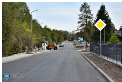
Przebudowa ul. 3 Maja na ukończeniu
