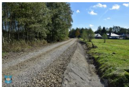
Trwa przebudowa drogi gminnej Domatków-Zagranicze
