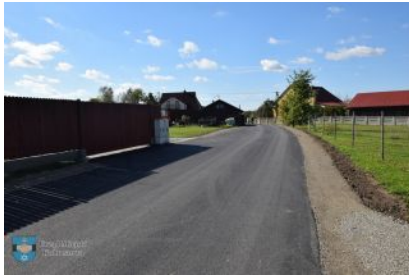
Przebudowana droga w Kolbuszowej Dolnej
