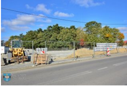
Budowa parkingu przy stadionie miejskim
