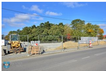
Budowa parkingu przy stadionie miejskim
