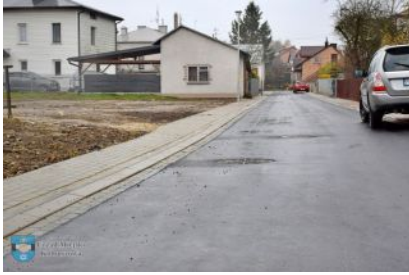
Zakończono prace na ul. Sosnowej i ul. Pileckiego
