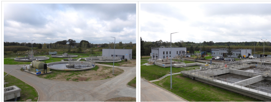
3. „Zmniejszenie poziomu zanieczyszczeń na terenie miasta Kolbuszowa poprzez przebudowę sieci kanalizacyjnej i wodociągowej
