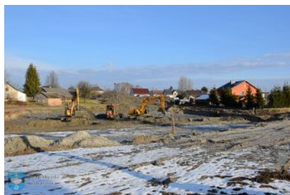
Budowa zbiornika retencyjno-infiltracyjnego w Kupnie
