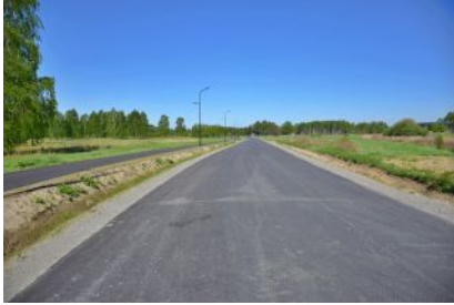
Przebudowa ul. Błonie w Kolbuszowej zakończona
