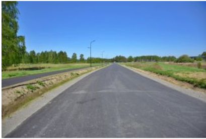
Przebudowa ul. Błonie w Kolbuszowej zakończona
