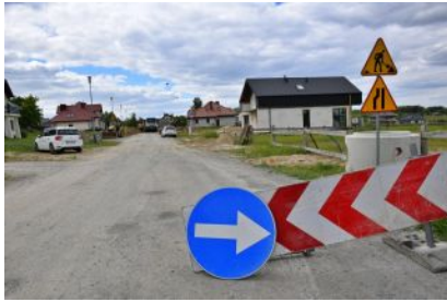
Przebudowa ul. Malwowej i Storczykowej
