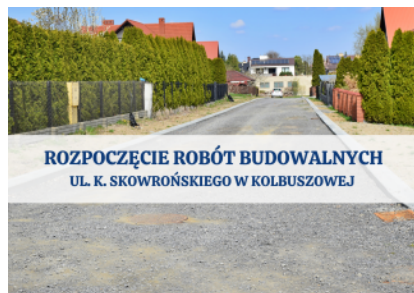
Przebudowa ul. K. Skowrońskiego w Kolbuszowej
