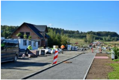
Przebudowa ulic Astrowej, Malwowej i Storczykowej
