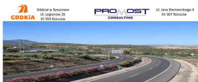
„BUDOWA DROGI ŁĄCZĄCEJ OBWODNICĘ NOWEJ DĘBY Z OBWODNICĄ KOLBUSZOWEJ W CIĄGU DK9, ODCINEK: KOMORÓW – CMOLAS”
