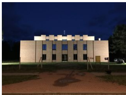
Budowa Muzeum Radia w Kolbuszowej
