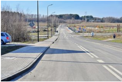
Przebudowa ulic: Malwowej, Astrowej i Storczykowej
