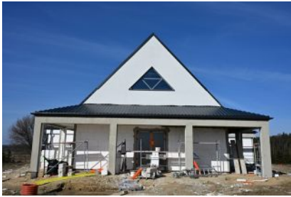
Budowa domu przedpogrzebowego przy cmentarzu komunalnym
