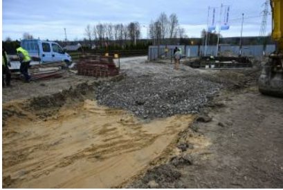
Prace przy budowie hydroforni
