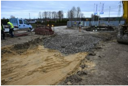
Prace przy budowie hydroforni
