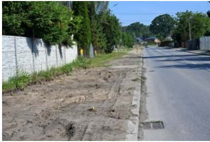
Budowa ścieżki pieszo-rowerowej w Kolbuszowej
