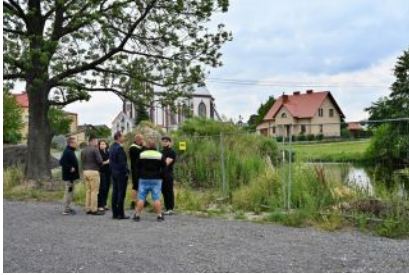
Wykonanie infrastruktury podziemnej na placu rekreacyjnym w Kupnie
