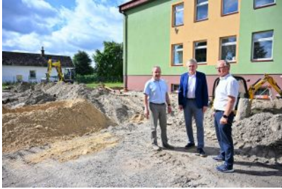
fot. Budowa parkingu przy Szkole Podstawowej w Kolbuszowej Górnej
