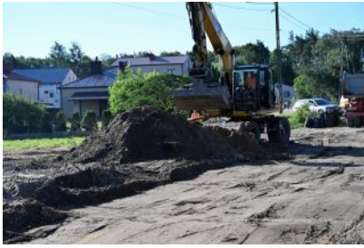
Przebudowa ul. Fredry w Kolbuszowej
