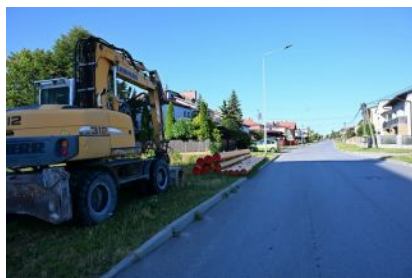
Trwają prace przy przebudowie ul. Partyzantów
