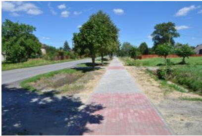
Budowa chodnika w Kupnie
