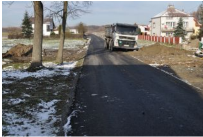
Przebudowa dróg gminnych
