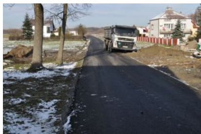
Przebudowa dróg gminnych
