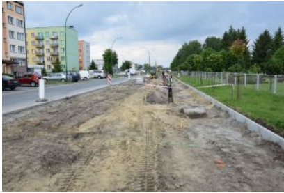
Prace na ul. Jana Pawła II
