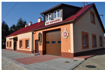
Budynek OSP Bukowiec
