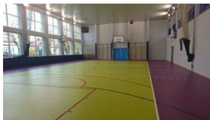
Remont sali gimnastycznej w SP nr 2
