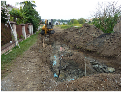
Budowa Kanalizacji- Kolbuszowa Górna
