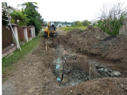
Budowa Kanalizacji- Kolbuszowa Górna
