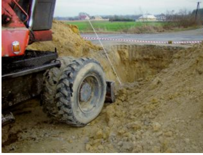
Budowa kanalizacji w Zarębkach
