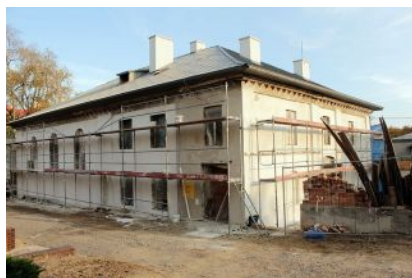
Remont budynku byłej synagogi
