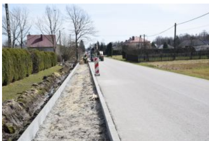
Budowa chodnika w Przedborzu
