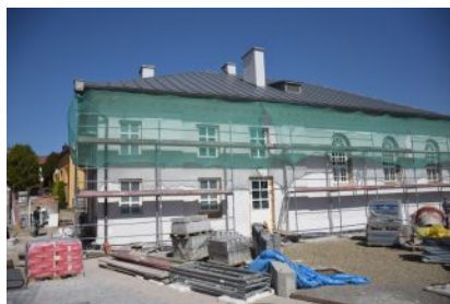
Remont budynku byłej synagogi
