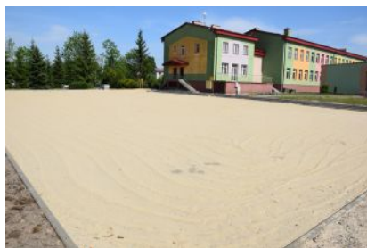
Budowa boiska w Kolbuszowej Górnej
