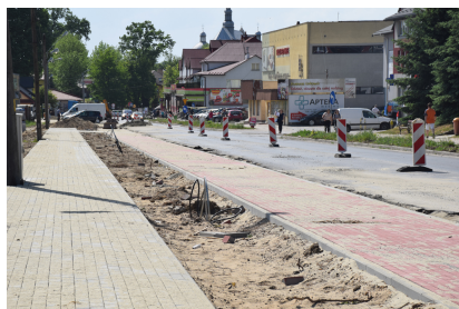
Przebudowa ul. 11 - go Listopada
