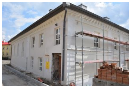
Modernizacja i adaptacja budynku dawnej Synagogi
