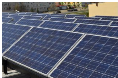
Budowa instalacji OZE
