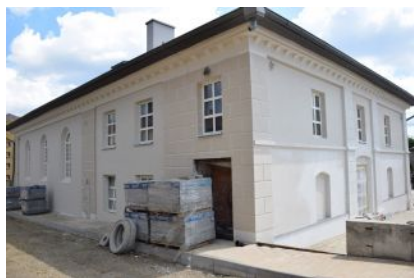
Remont budynku byłej synagogi
