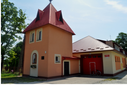
Budynek OSP Przedbórz
