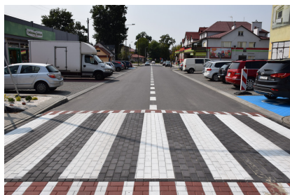
Przebudowa ul. 11 Listopada
