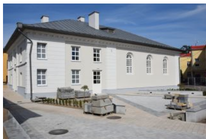
Modernizacja i adaptacja budynku dawnej synagogi
