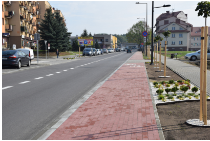
Przeгляд inwestycji drogowych
