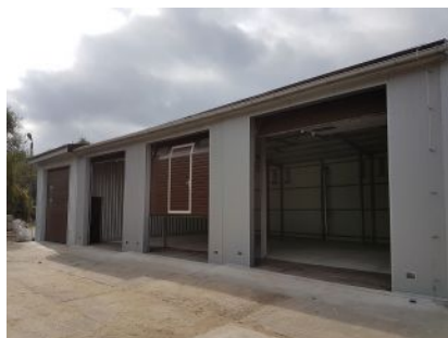
Punkt Selektywnej Zbiórki Odpadów Komunalnych
