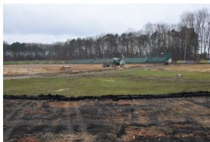
Przebudowa stadionu w Kolbuszowej
