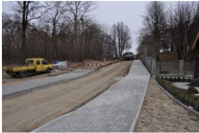
Budowa chodnika w miejscowości Kupno
