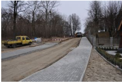
Budowa chodnika w miejscowości Kupno
