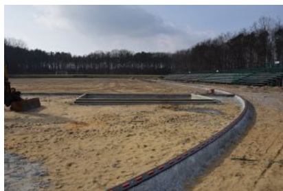
Wznowienie prac na stadionie w Kolbuszowej
