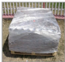
Prawidłowo przygotowane do transportu zdemontowane płyty azbestowo cementowe
