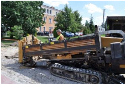
Budowa sieci światłowodowej w Kolbuszowej
