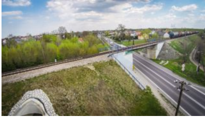
Remont wiaduktu w Widełce
