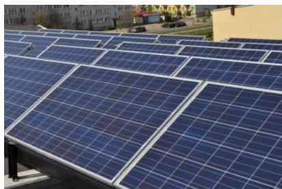
Budowa instalacji OZE
